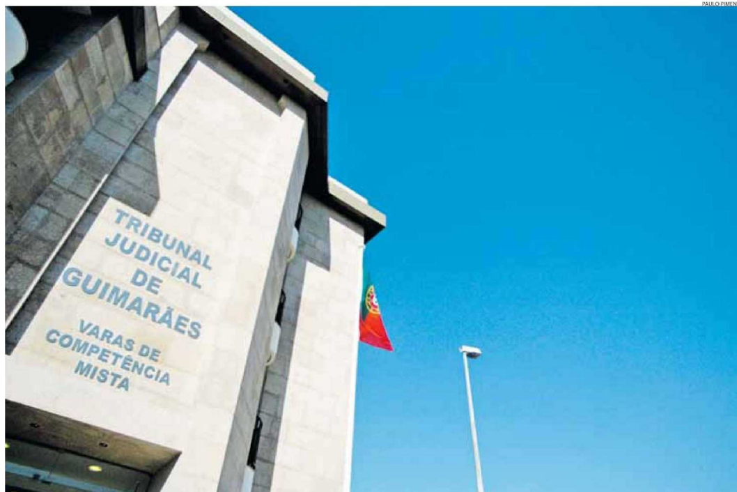
Obra vai acarretar um investimento a rondar os 10,5 milhões e juntará valências que estavam dispersas
