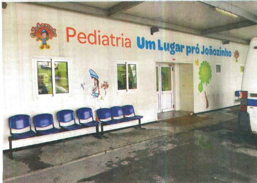
Pediatria do Hospital S. João, no Porto, funciona em contentores
